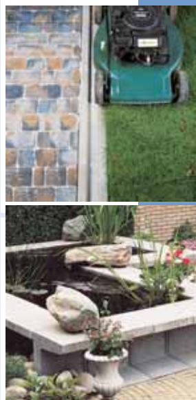
Bassin d'eau réalisé en éléments en U
