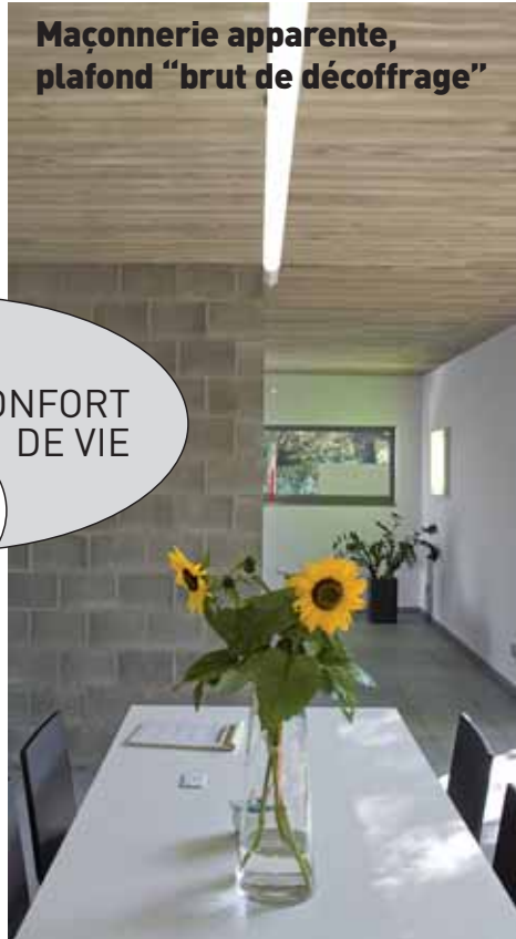
Sol lissé, escalier et plafond sans finition
