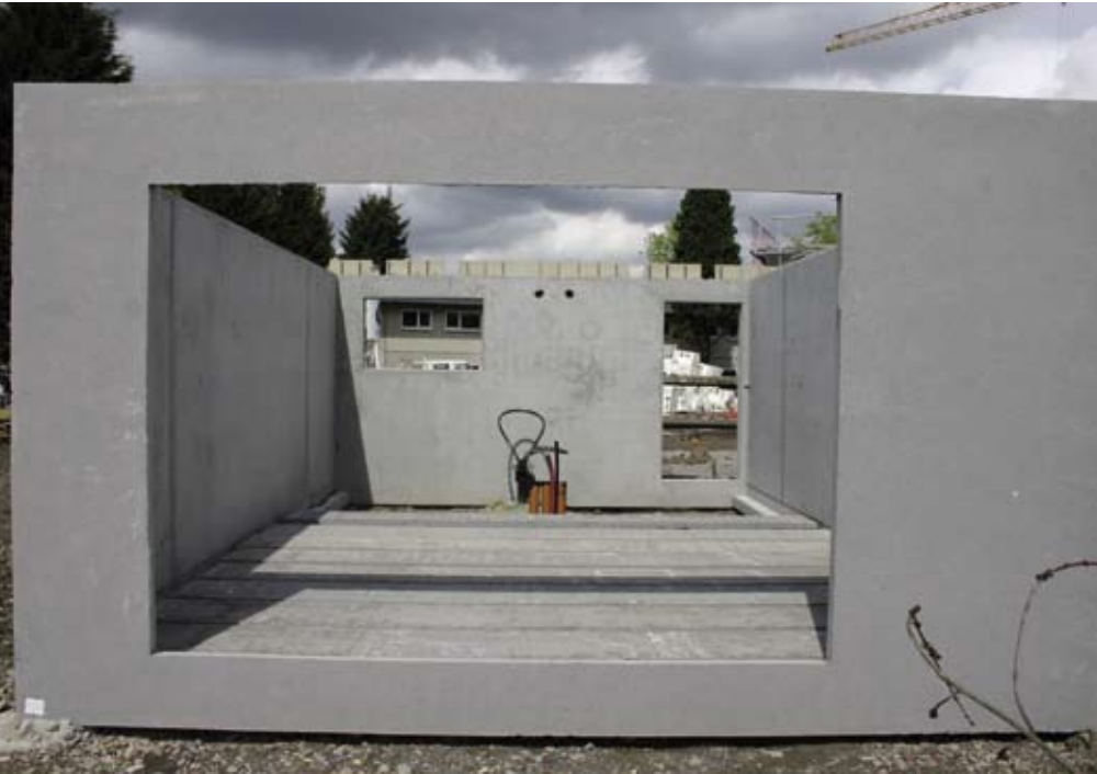
Aangezien het gaat om gewapende dragende elementen bleken funderingsbalken niet nodig.
