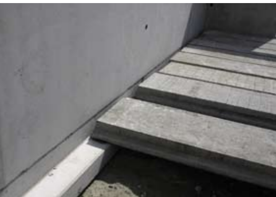
De vloerplaten rusten op twee L-vormige gevel-elementen.
