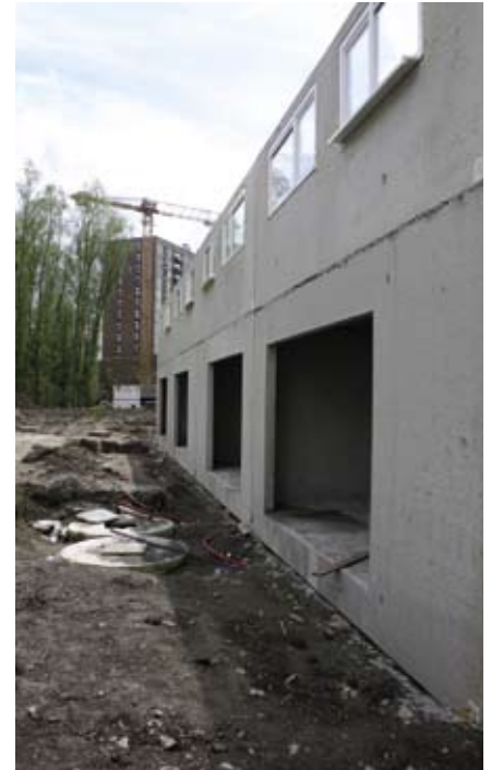
Elk huis beschikt over een regenwaterput.
